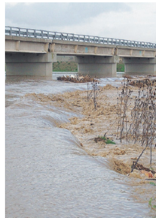
ALLUVIONE L'esondazione del Cervaro nel 2017
