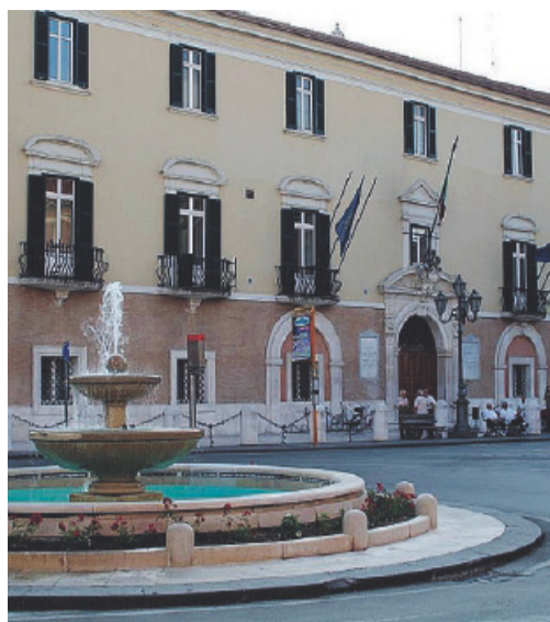
FOGGIA Palazzo Dogana, sede della Provincia
