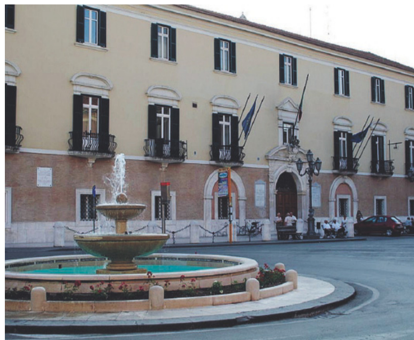
FOGGIA Palazzo Dogana, sede della Provincia
