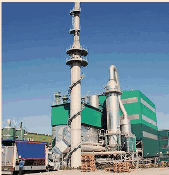
Impianti a rischio. Il termovalorizzatore A2a di Corteolona nel Pavese
