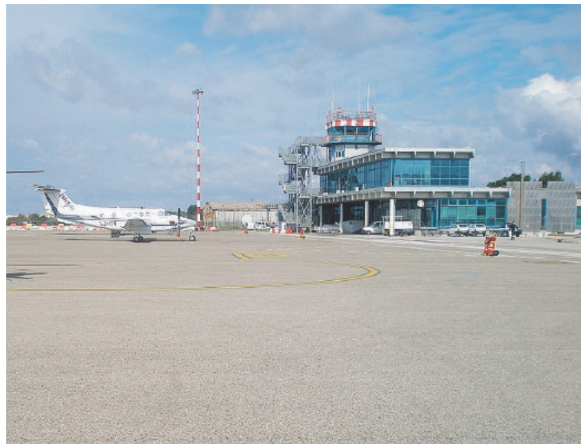
PISTA DA ALLUNGARE L'aeroporto Gino Lisa: il piano industriale di Aeroporti di Puglia verrà presentato mercoledì 27 a poche settimane dall'inizio lavori sulla pista dello scalo dauno che avrà una lunghezza di 2mila metri
