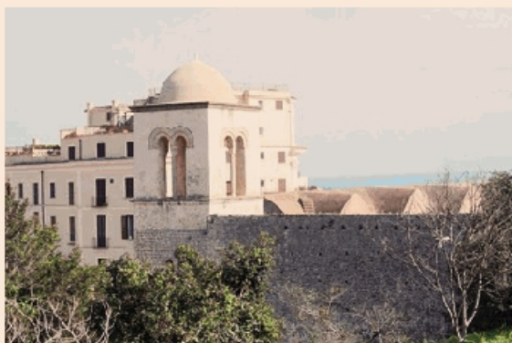
Ex Caserma Vittorio Emanuele II Ex convento ed ex caserma Vittorio Emanuele II, l'edificio (4.300 mq di superficie lorda) è a due km dal centro di Gaeta (Latina)
