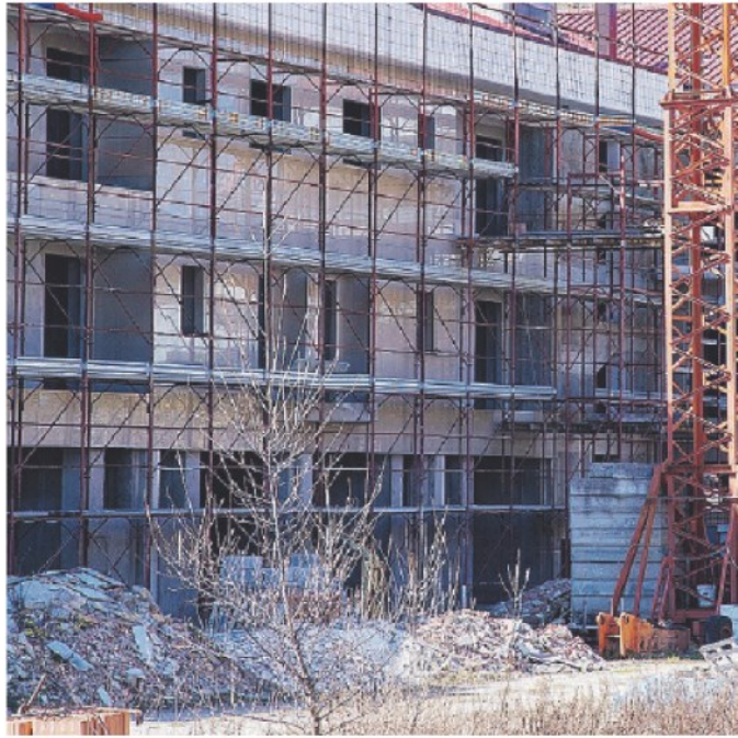
DEMOLIZIONE E RICOSTRUZIONE Bonus anche per l'antisismica
