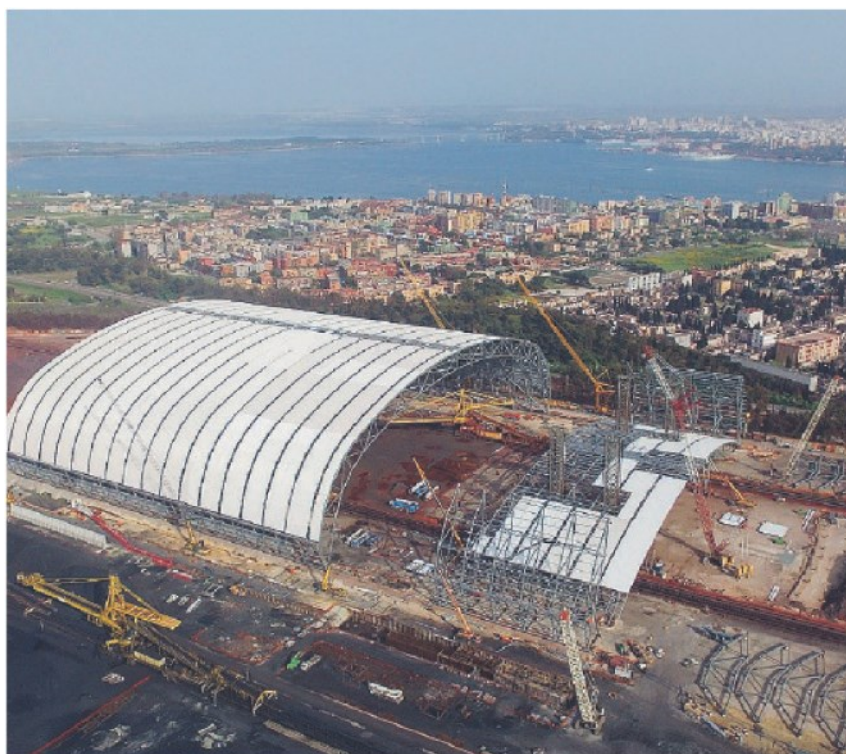
TARANTO L'area industriale della acciaieria Arcelor Mittal in particolare il cantiere della copertura dei parchi minerali
