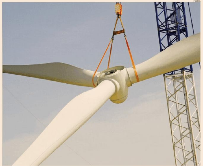
Energia pulita. Le fasi di assemblaggio per la messa in funzione di una pala eolica
