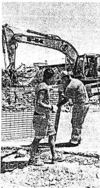
I lavori stradali proseguiranno per qualche mese
