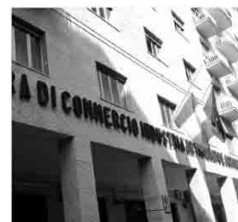
L'immobile di via Dante
